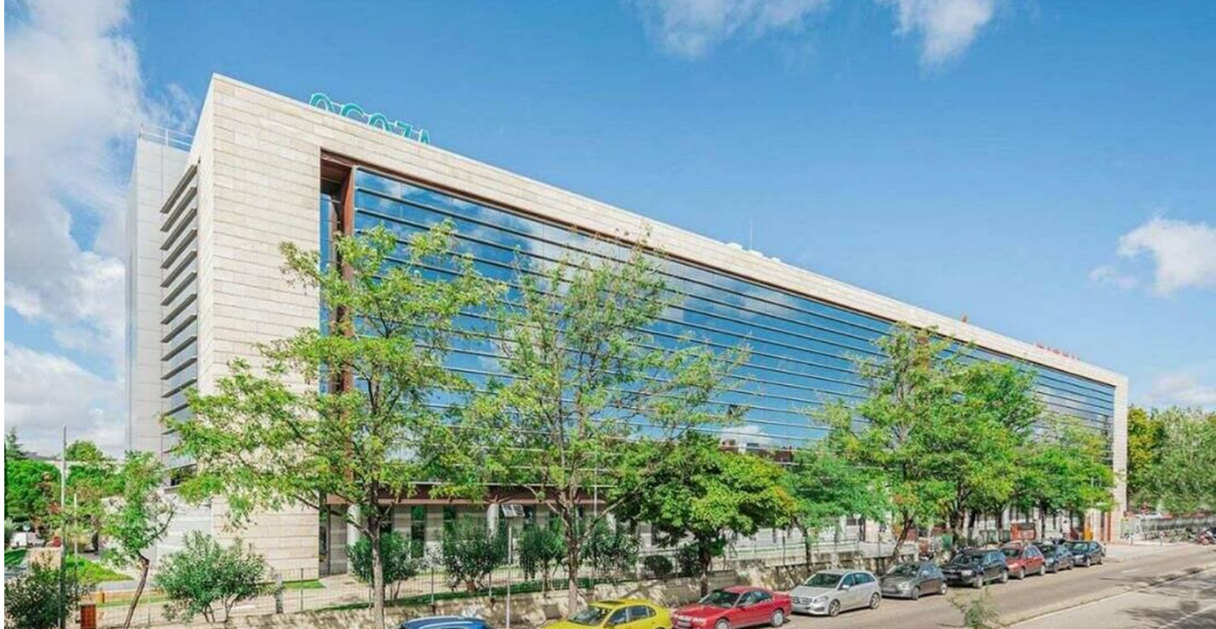
Exterior del edificio Amura.
